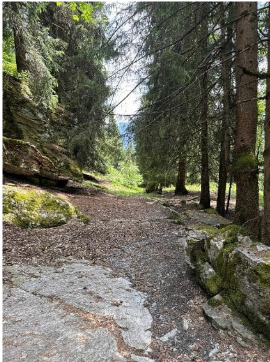
Foto 12: Gefahrenkataster Nr. GK02: Der markierte Wanderweg / Alpweg sowie Nr. GK03 Brücke in der Zone S3 stellen keine Gefährdung dar für das Trinkwasser (Aufnahme 08.06.2026).
