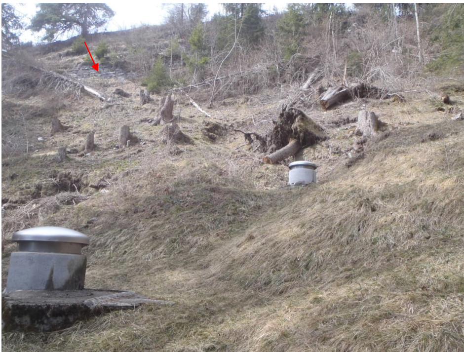
Foto 4: Quelle Mulin (vor der Sanierung im Jahr 2020, Aufnahme 26.03.2020). Im Bildhintergrund ist der anstehende Fels sichtbar (roter Pfeil).
