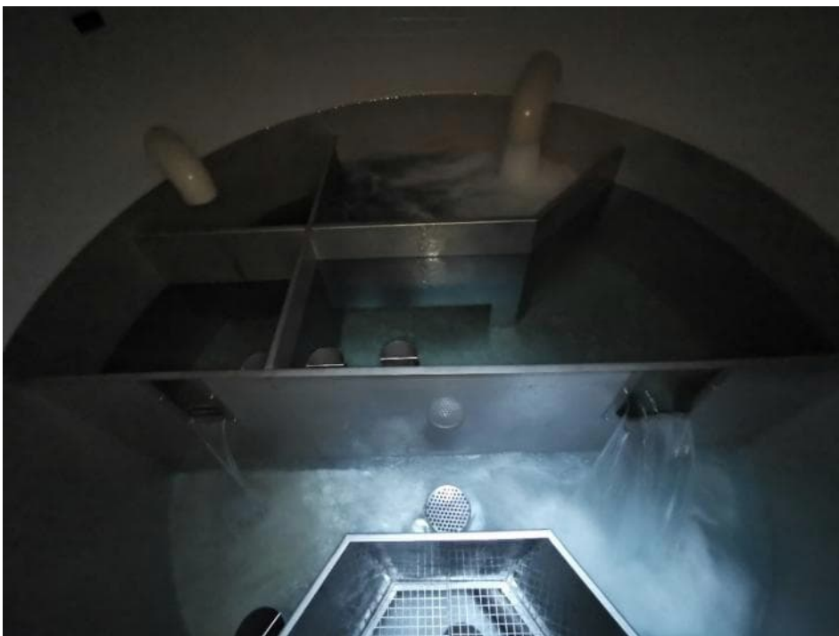
Foto 8:: Neue Brunnenstube Mulin mit separaten Einläufen für Haupt- und Nebenquelle (Aufnahme 13.11.2020).
