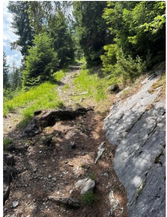
Foto 13: Gefahrenkataster Nr. GK04: Der markierte Wanderweg / Alpweg / Forstweg in der Zone S3 stellt keine Gefährdung dar für das Trinkwasser (Aufnahme 08.06.2026).
